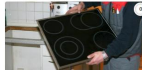
Elektrische Geräte projektieren, installieren und in Betrieb nehmen
