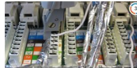
Bürosystemtechnik installieren und in Betrieb nehmen
