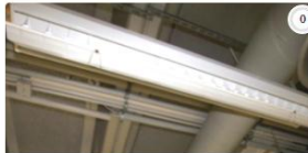
Beleuchtungsanlagen projektieren, installieren und in Betrieb nehmen
