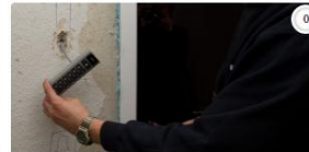
Sicherheitsanlagen installieren und in Betrieb nehmen
