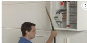
Energieversorgungsanlagen installieren und in Betrieb nehmen
