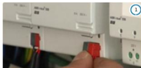
Gebäudesystemtechnik installieren und in Betrieb nehmen
