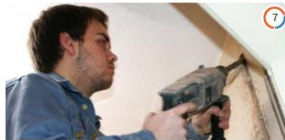
Standard-Elektroanlagen installieren und in Betrieb nehmen
